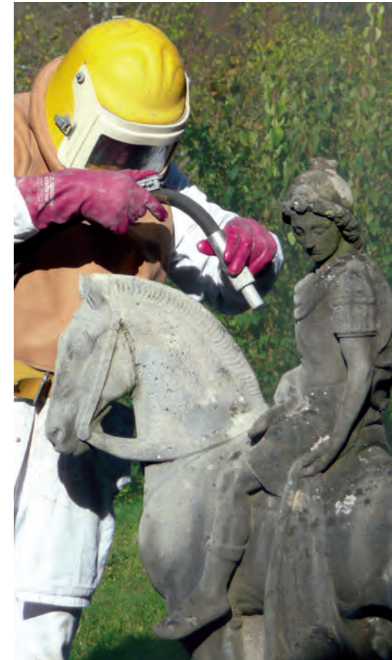
Schwerstarbeit unter den Klosterarkaden: Bruder Wolfgang beim Sandstrahlen der Martinsstatue, die mittlerweile wieder in hellem Glanze die restaurierte Fassade der alten Pforte krönt.
